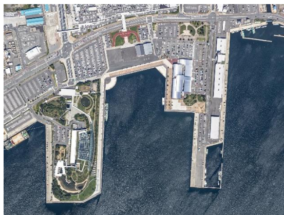
小名浜港1号ふ頭 いわき・ら・ら・ミュウ 2階テラス
