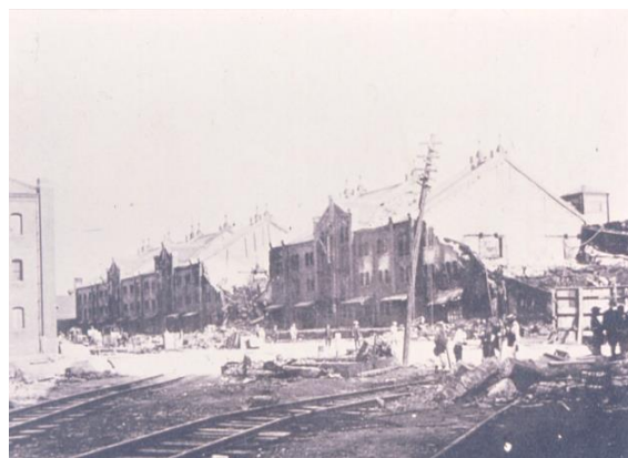
関東大震災で被災した1号館
