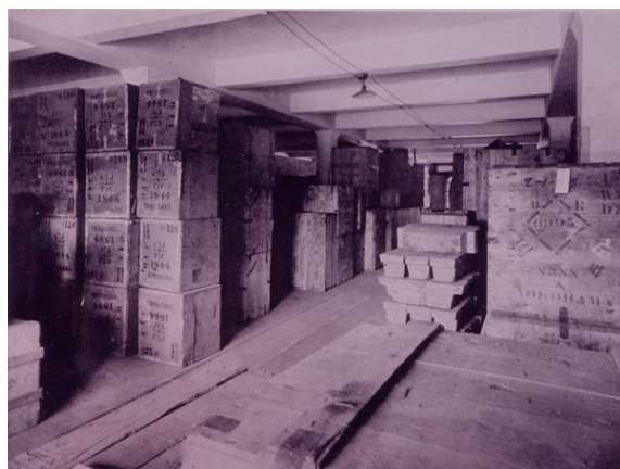
倉庫として使用されていた様子
