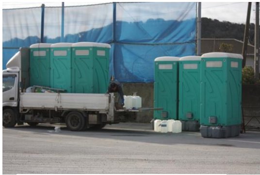
仮設トイレ・手洗い設置作業
