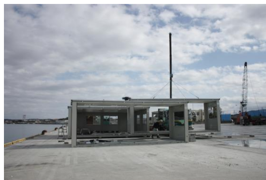
館山港耐震強化岸壁
