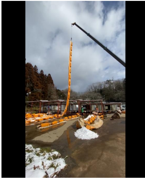
吊り作業状況チェック 保管状況チェック 屋外保管（遮光シート）
