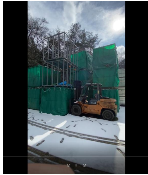
吊り作業状況チェック 保管状況チェック 屋外保管（遮光シート）
