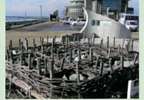
粗朶沈床の模型 （エッセル堤ファンクラブ作成）
