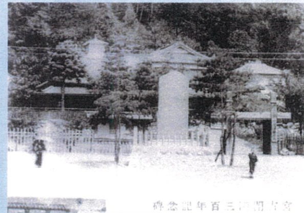
下閉伊郡役所(現在の市役所分庁舎)前の開港記念碑 昭和10年(1935)頃
