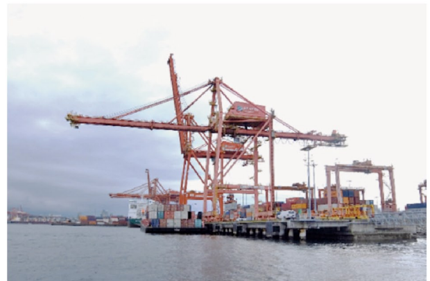
バンクーバー港のコンテナターミナル
