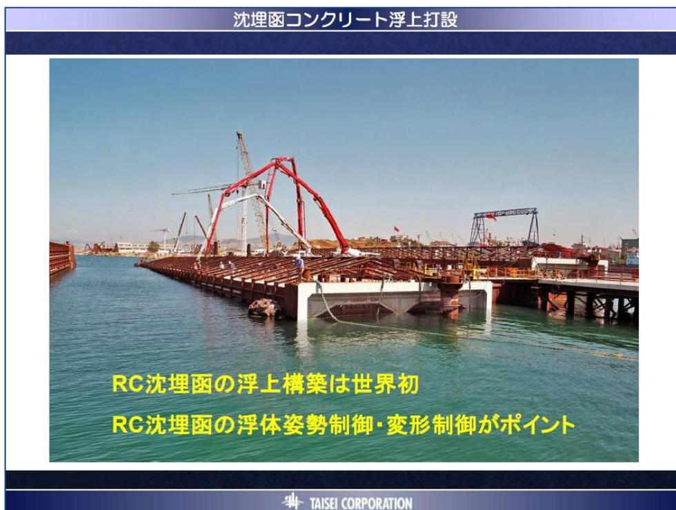
ドライドックで製作した函体を持ってきて浮上打設といって浮いたところに上からバランスを取りながらコンクリートを打った写真です。浮上構築は世界初ということで偏ると変形したり、おかしなことが起きますので姿勢制御をしながらコンクリートの打設の順番を配慮してやりました。
