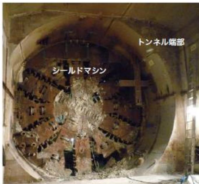
これがシールドマシンが沈埋函にドッキングした状態です。
