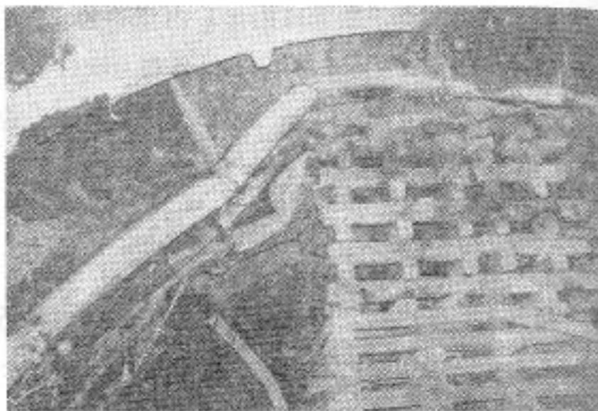
第 5 本坑上半支保工変状及び補強（1 回目）
