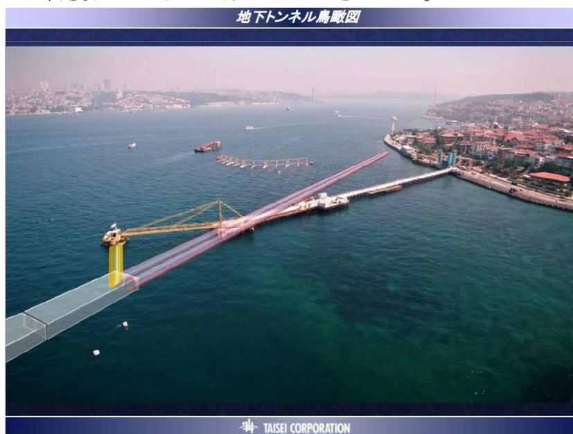
沈埋函の接合は水圧接合ですね。水を抜いて水圧でガスケットにてドッキングさせるといことです。せん断キーがありますね。これが地上にアクセスするためのシャフトです。シャフトは、かなりの流速のところで設置しなければならないのでフィンをつけたりいろいろな工夫をして下に降ろした沈埋函とシャフトで出入り口を作った時の状況です。どういうことかといいますとこの部分ですね。沈埋函を一旦設置して降ろしてアクセスするのに、栈橋を持ってきてここから渡って降りてくる。階段を降りて行ってこの中の作業をするというようになっております。
